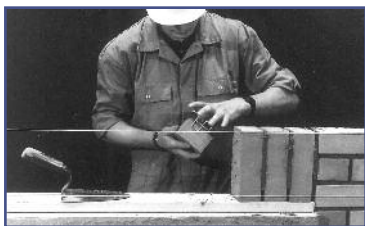
Eerst dient mortel op de steen aangebracht. Dan wordt de lateihaak in de mortelspecie gedrukt, waarna het metselwerk verder gaat.
