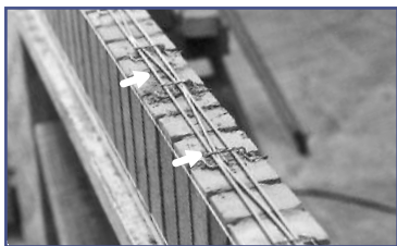
Eenmaal de rollaag is afgewerkt wordt een Murfor® element in de lateihaken geschoven.
