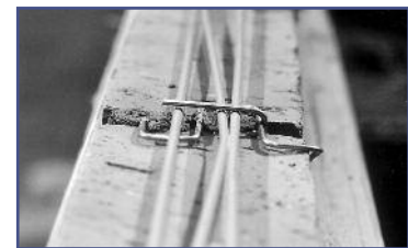
Het Murfor®-element zit verankerd onder de arm van de lateihaak.
