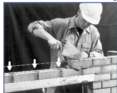
Bij de realisatie van een streklaag wordt in elke voeg een lateihaak gemetseld.
