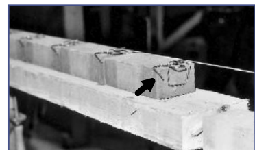
Het haakeinde dient aan te sluiten op de achterzijde van de steen. Hierdoor bekomt men een correcte positionering van de verschillende lateihaken.
