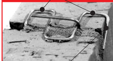
Eerst dient mortel op de steen aangebracht. Dan wordt de lateihaak in de mortelspecie gedrukt, waarna het metselwerk verder gaat.
